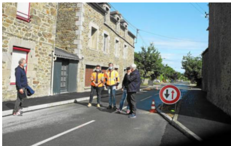
Des travaux engagés rue de Dinard avec pose de chicanes.
